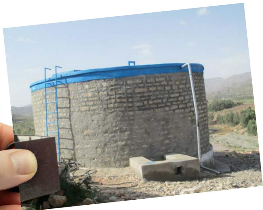
las infraestructuras necesarias para garantizar el suministro de agua potable a la población: un nuevo depósito de doscientos metros cúbicos para la regulación de agua potable proveniente de pozos, conexión de diferentes sectores de la ciudad, implantación de un sistema de cloración por gravedad, y formación del personal técnico y administrativo del Water Supply.
